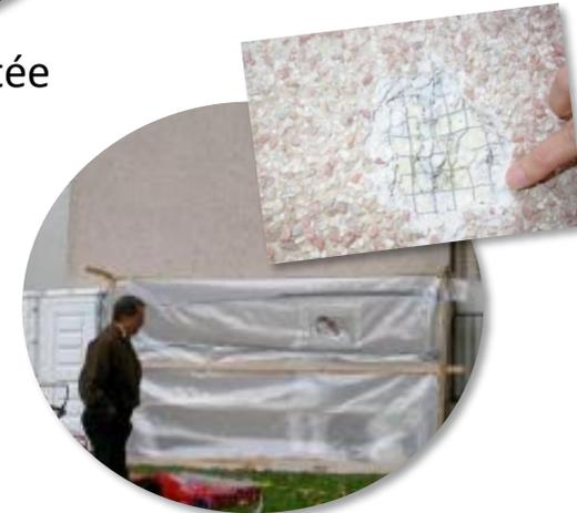
Bourre d'amiante sous un revêtement d'aspect béton lavé
