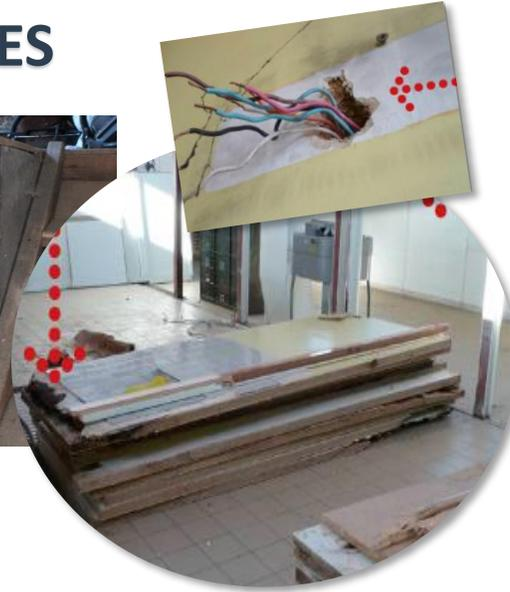
Panneaux de cloisons légères ou préfabriquées : fibro-ciment collé sur chaque face
