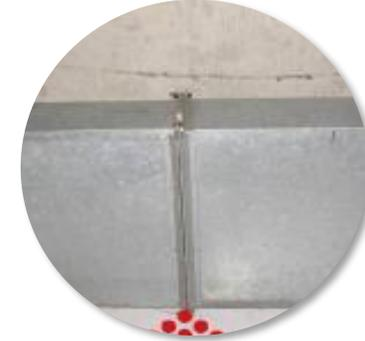
Joints amiantés sur conduit de vapeur
