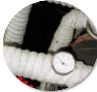
Calorifugeage à base de tresse amiantée
