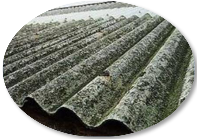
Plaques en fibres-ciment
