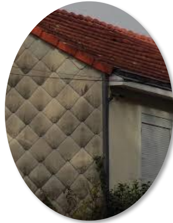
Ardoises en fibres-ciment sur un bardage
