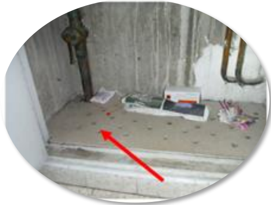
Plaques de gaine technique séparatrice entre niveaux
