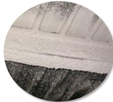
Progipsol (plâtre + amiante) sur des panneaux vissés de plafond
