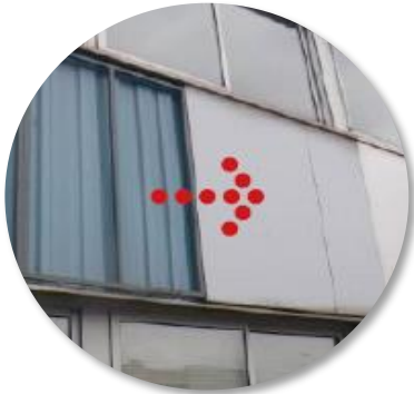
Plaque en fibres-ciment sur un bardage
