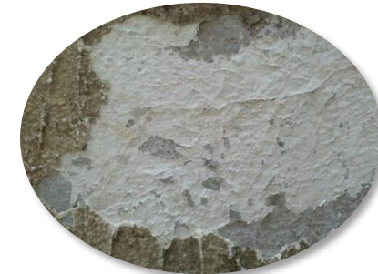
Enduits de façade
