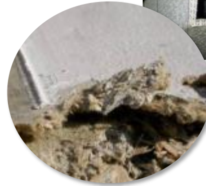
Coffrages perdus (carton-amiante, fibres-ciment, composite)
