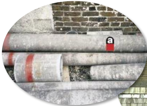
Conduits de ventilation et de cheminée
