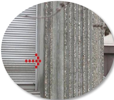
Joint de façade d'un panneau-sandwich
